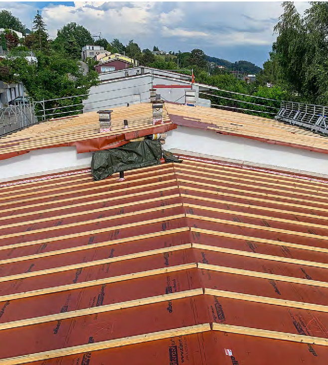
Dachsanierung, Installation Photovoltaikanlage und Isolation der Estrichböden bilden ein Gesamtpaket.
