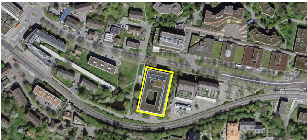
Abbildung 1 Luftbild im Bereich Worblentalstrasse 68 Ittigen, Transformationsgebäude im Bildmittelpunkt (Swisstopo)
