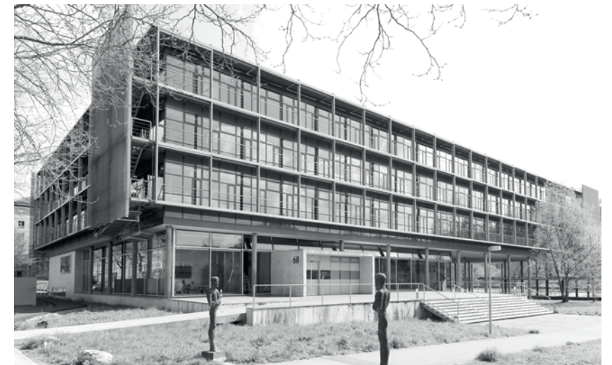
Ansicht Parkseite Worblentalstrasse - Bestand
